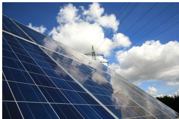
Legende Foto: Solarstromanlage im Netzverbund (Quelle: Rainer Sturm, pixelio.de)
