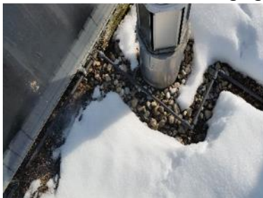
Themische Solaranlage 25 m 2 Einsparung durch Weglassen Dämmung CHF 1'400.00 Geringere Solarente in 25 Jahren CHF 1'900.00
